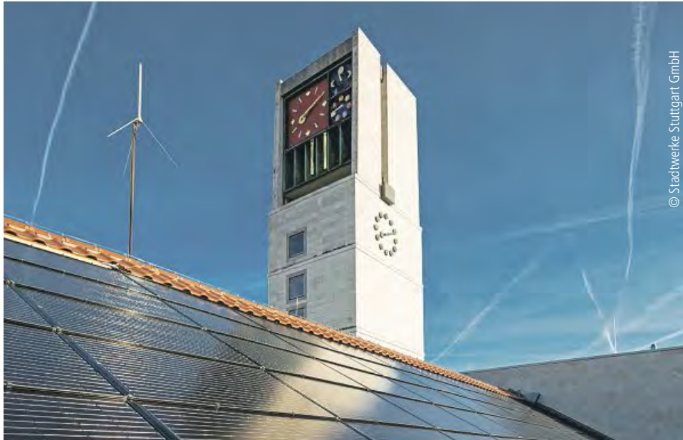
Solarstrom auf dem Rathausdach
