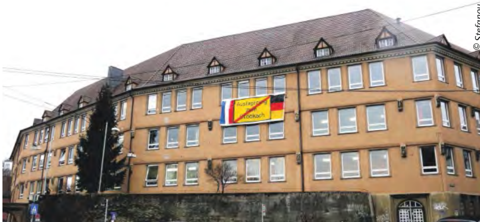
Dem Wagenburg Gymnasium stehen aufwendige Sanierungsarbeiten bevor.
