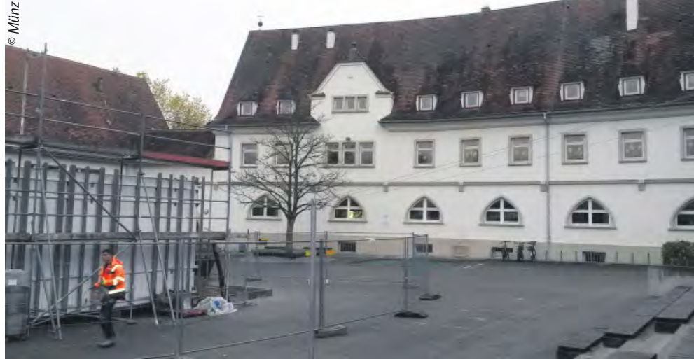
Die Grundschule Kaltental - eine von vielen Sanierungsbaustellen
