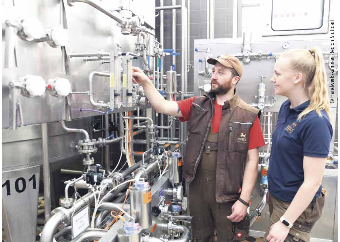
Technische Anlagen warten, wie hier in einer Brauerei, gehört in vielen Handwerksberufen zur Ausbildung.
